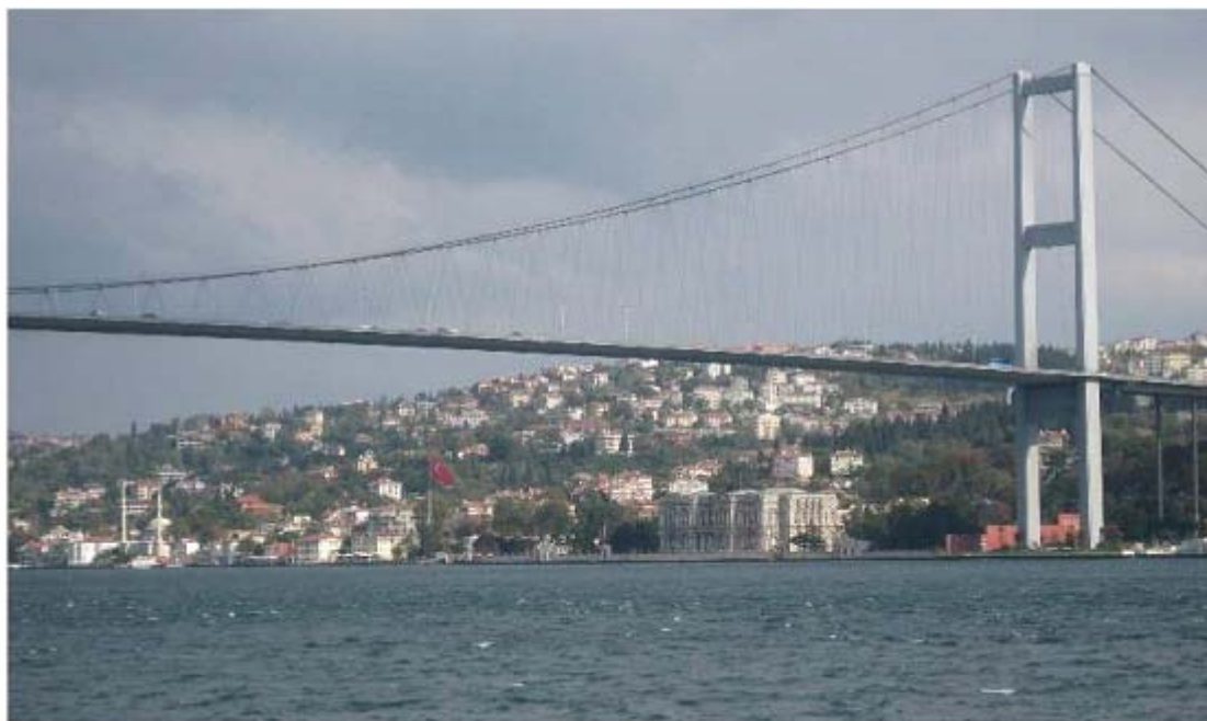
第1ボスポラス橋 対岸に見えているのはアジア側の住宅街
